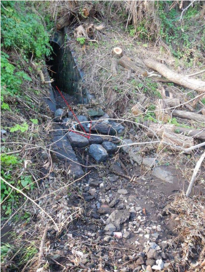
Figura 3. La restante parte delle acque provenienti dal promontorio viene raccolta in un piccolo canale (di nuova costruzione) che scarica nel sottopassaggio raffigurato (confinante con la proprietà del socio) , da dove a considerevole velocità si riversano negli appezzamenti coltivati.
