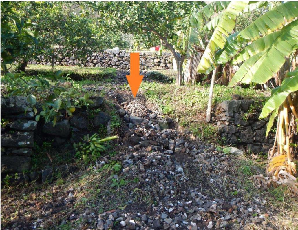
Figura 4. Distruzione delle muraglie, erosione e trasporto di detriti causato dalle acque provenienti dal sottopassaggio delle fig.3.
